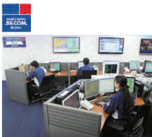
24時間ビル遠隔監視システム 「ビルコム」
